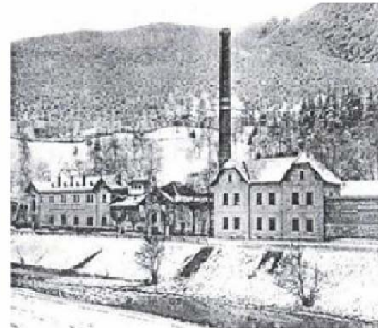
Figura 6.2. Centrala hidroelectrică Sadu I.
