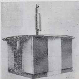
Fig. 363. Radiofarul omnidirecțional VOR.
